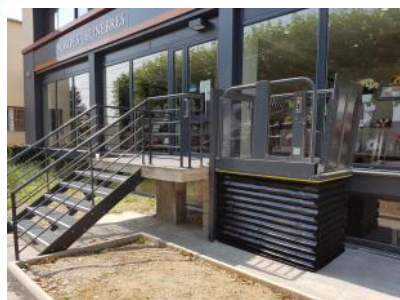
Mécanisme protégé par soufflet
